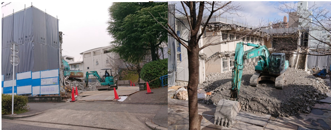
カトリック会館取り壊し
