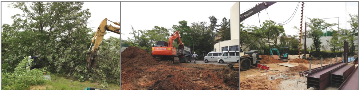
樹木伐採・アスファルト撤去
